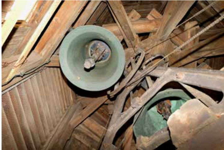
Blick von unten in die beiden Glocken des derzeitigen Sterbegeläuts im Dachreiter
